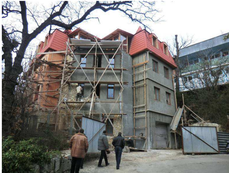
Проверка строительных работ в г. Алушке
